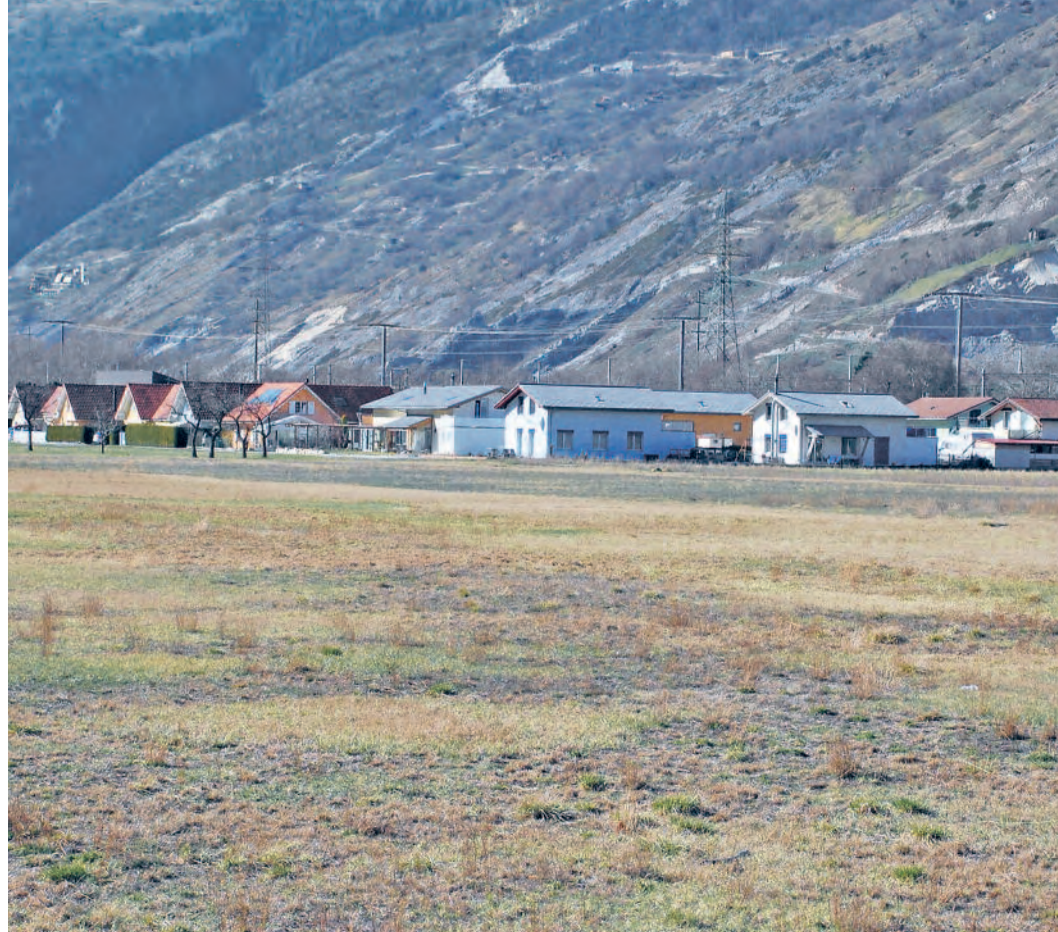
Hier soll eine Siedlung entstehen. Das Terrain, auf dem dereinst 26 energieautarke Häuser gebaut werden sollen, befindet sich im Turtig vor dem «Edendorf».
