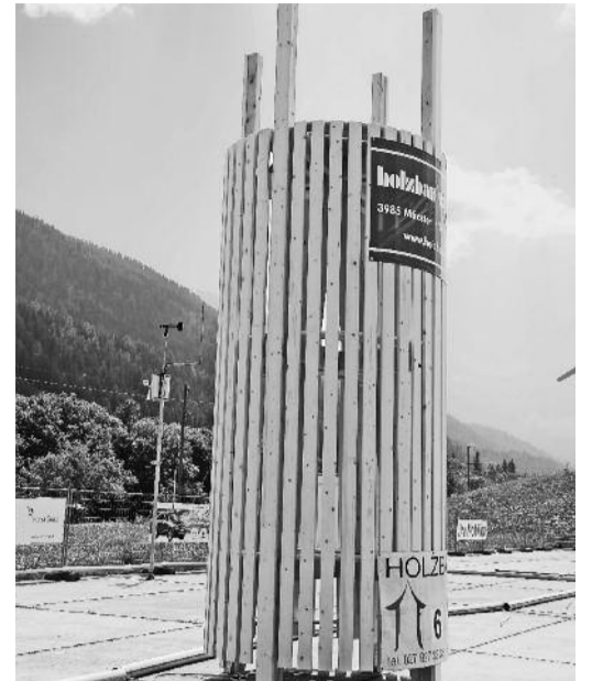
Bewährtes Prinzip. Holzwindkraftwerk, VSSM Oberwallis.
